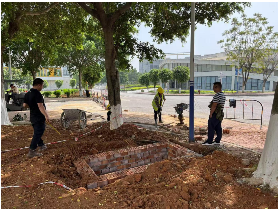
电力施工过程中进行验收
