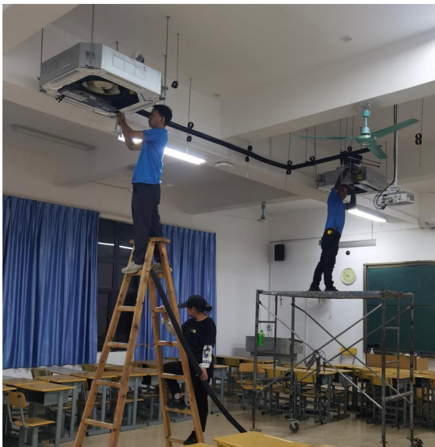
第一教学楼空调安装进行中
