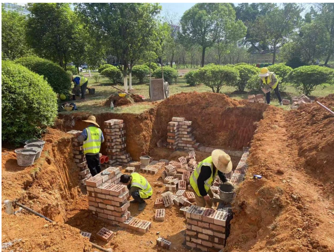
为第一教学楼新建变压器修建基础
