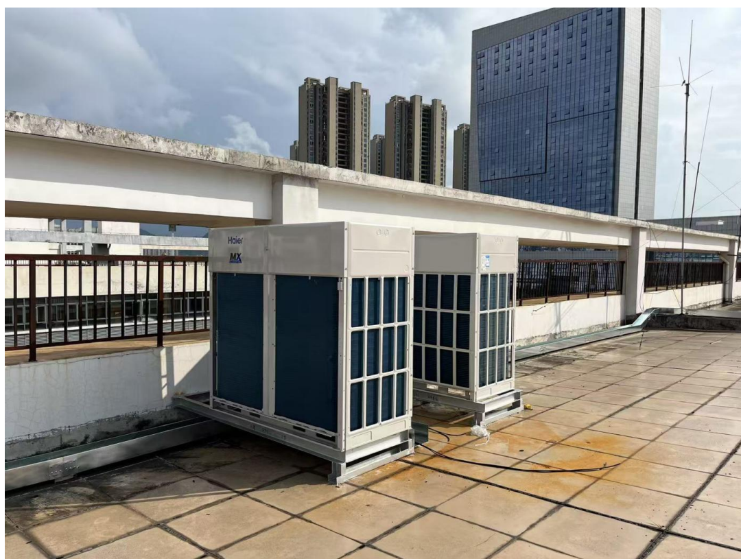
第二教学楼空调外机安装到位
