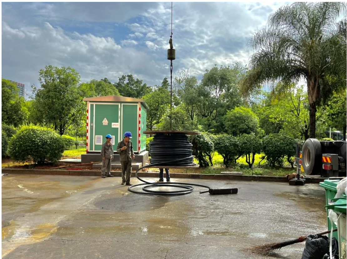
为第一教学楼空调吊装供电电缆
