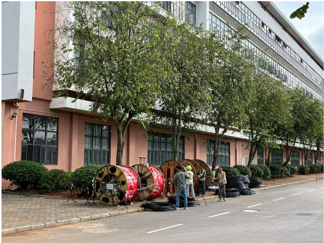
电力扩容电缆敷设
