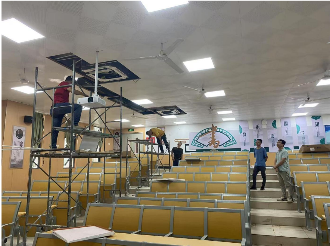
考研自习教室空调安装中
