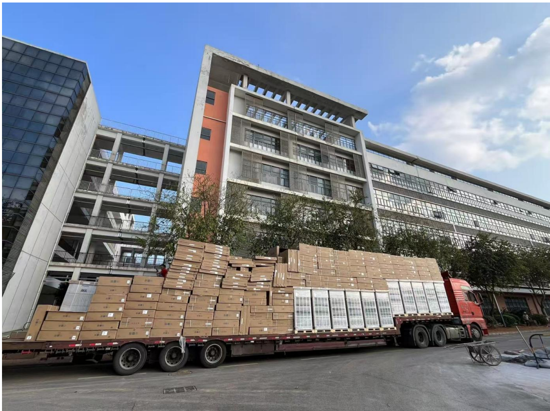
空调设备运抵
