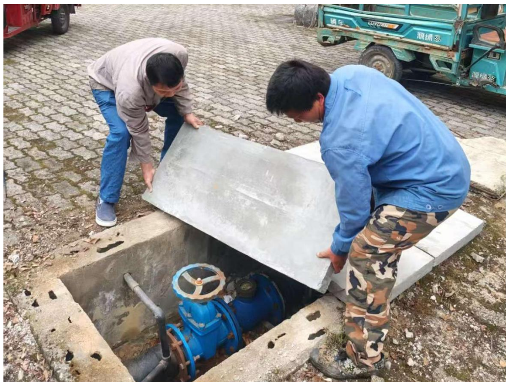
更换第八栋宿舍楼室外损坏的供水井盖
