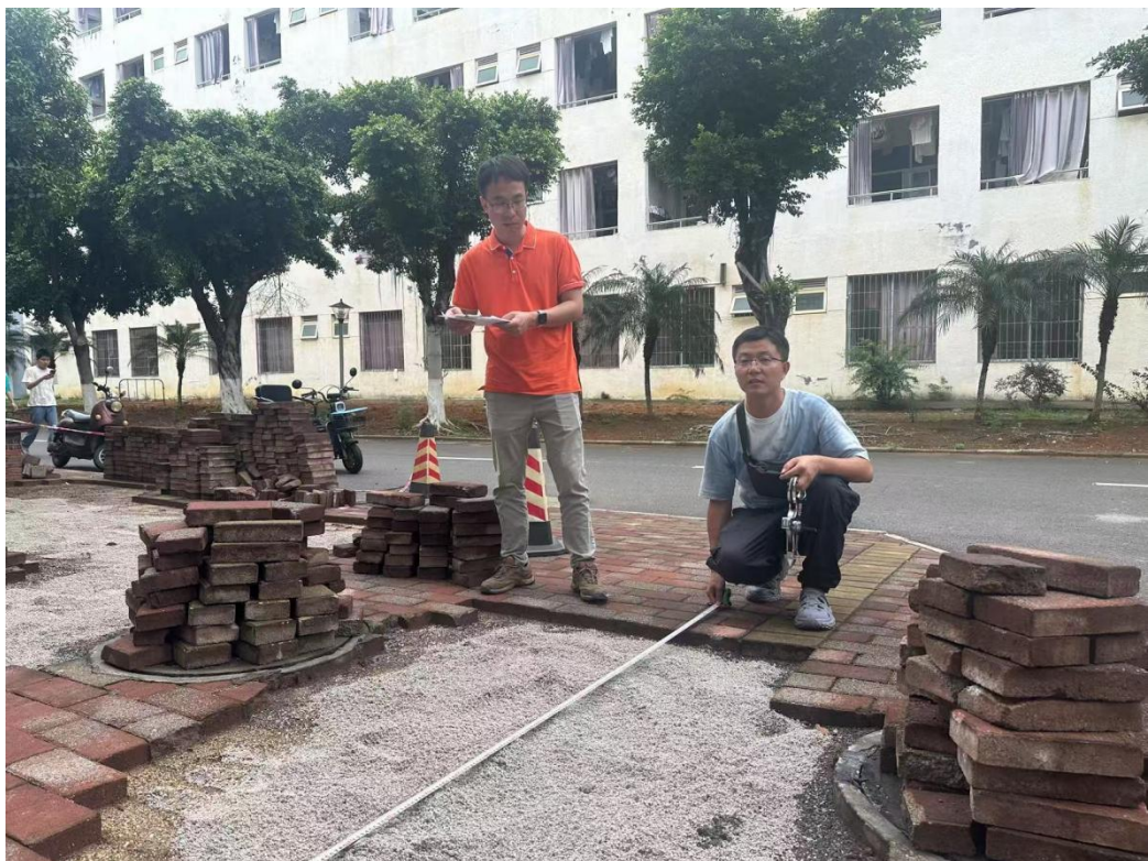
同施工单位对透水砖路面翻新项目进行收方
