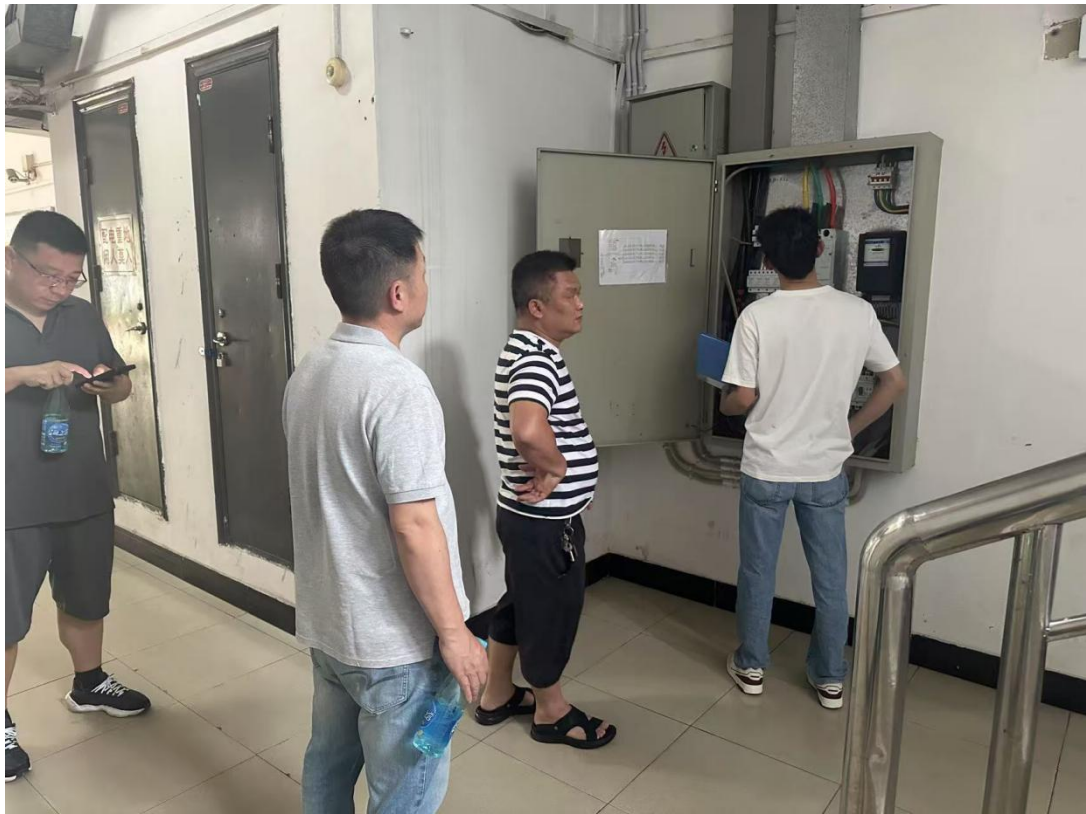
现场复核南校区分体空调设备采购及安装项目相关材料
