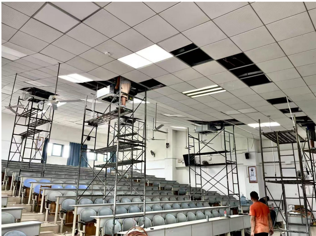
阶梯教室空调安装中
