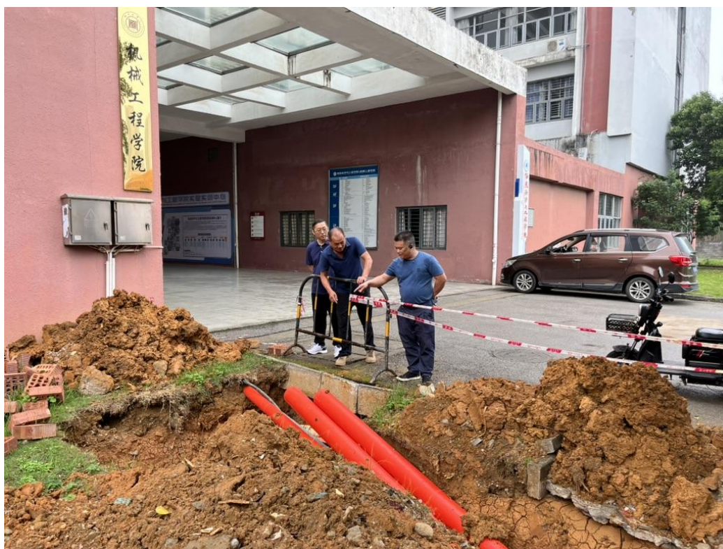
与施工方确定电力增容工程电缆井顶管走向
