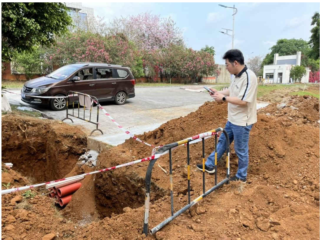
后勤基建处处长在电力增容施工现场指导工作
