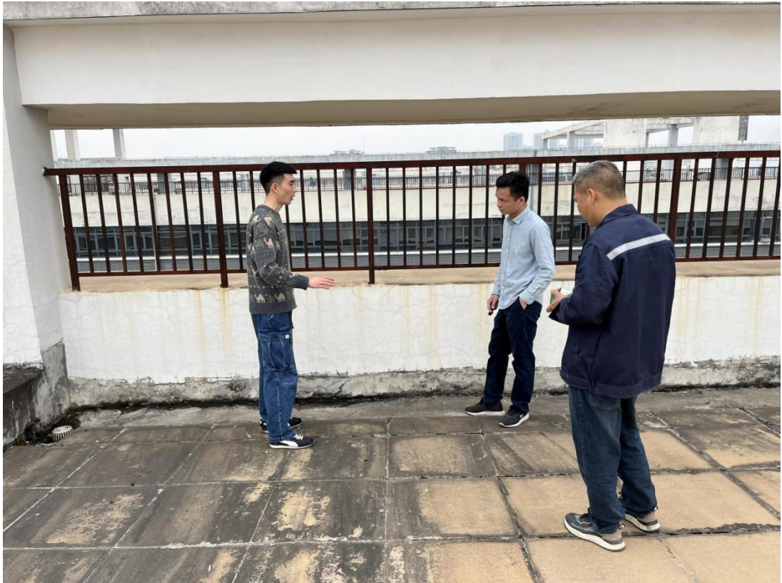
与施工方确定空调外机安防位置和放置
