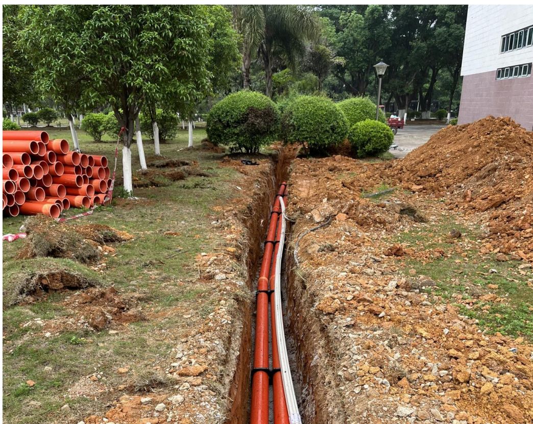
第一教学楼电缆敷设中
