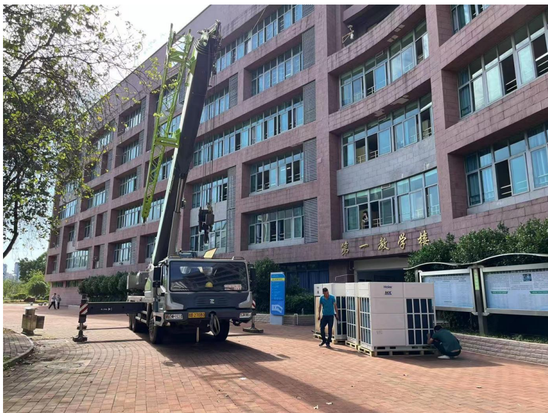
吊装空调设备
