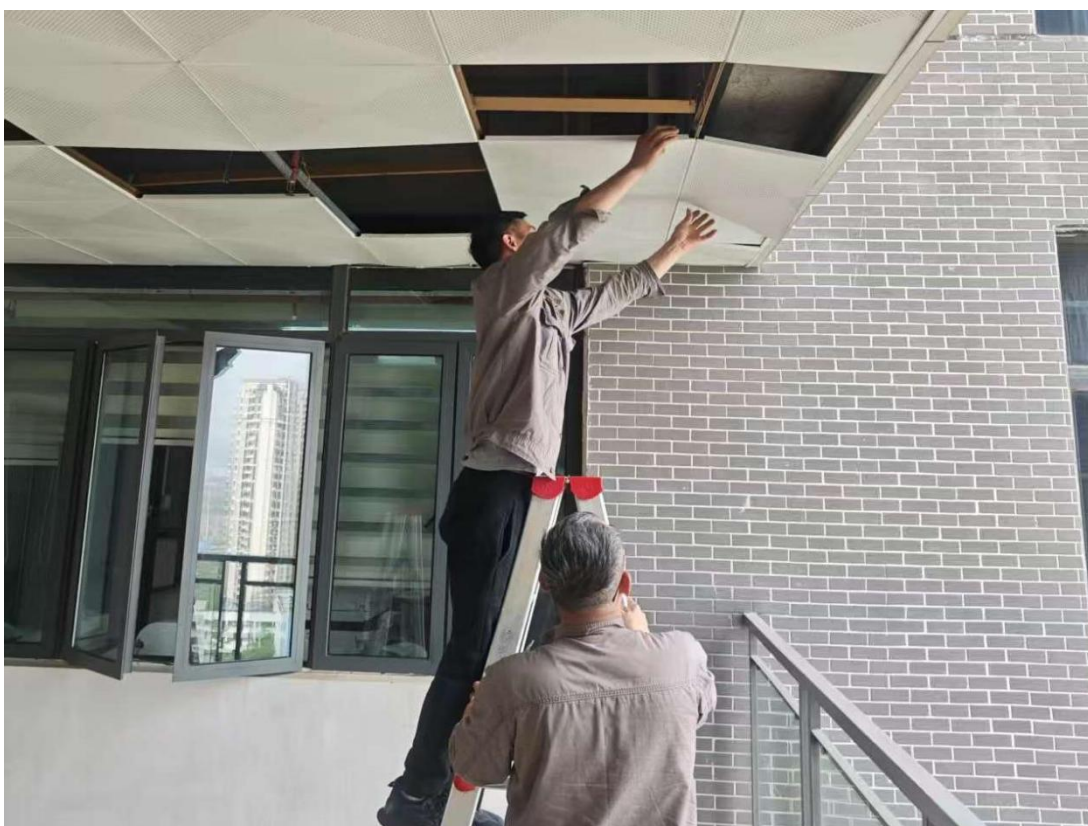
对科教楼走廊吊顶存在问题进行维修
