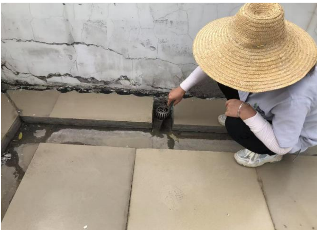
保持天台地面清洁和排水系统通畅
