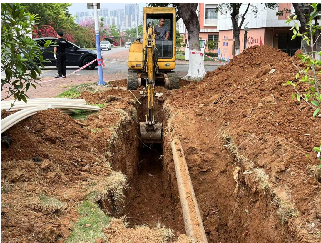
电力增容施工中
