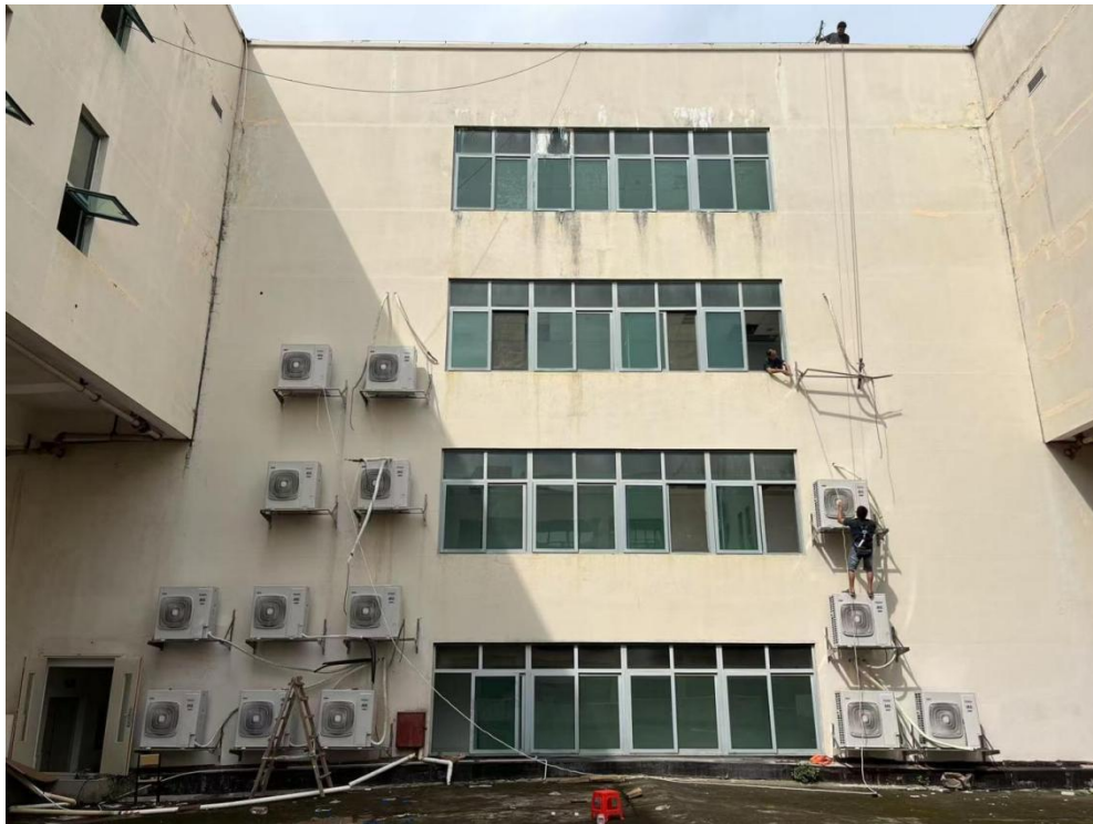
图书馆空调外机安装中
