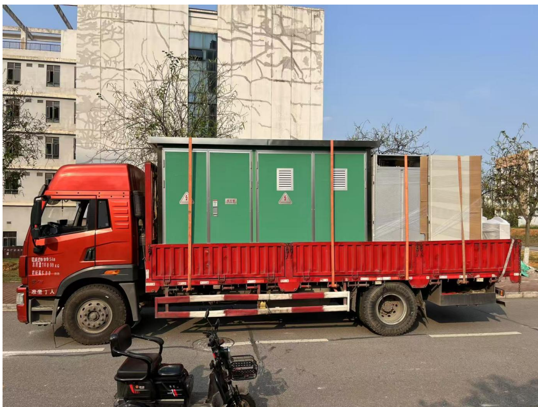
电力扩容材料运抵
